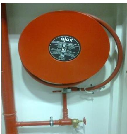
Figuur 20: Haspel met axiale voeding MET muurhydrant of DSP-mondstuk Ø 45 mm
