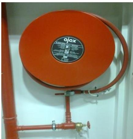
Figure 20 : Dévidoir à alimentation axiale AVEC hydrant mural ou raccord DSP Ø45mm
