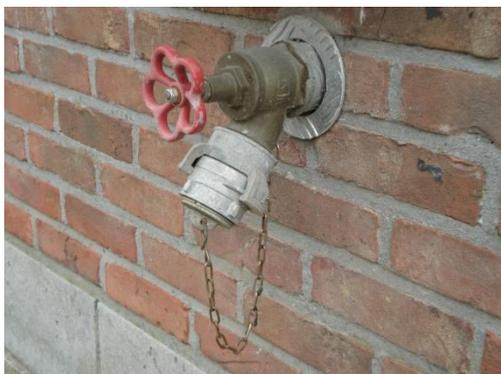
Figure 19 : Hydrant mural ou raccord DSP Ø45mm seul
